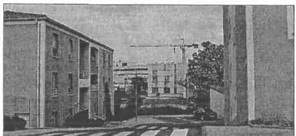
La Coronelle poursuit toujours sa rénovation. Après la sortie de terre d'un premier ensemble de logements en 2012, la démolition du dernier collectif doit intervenir.
